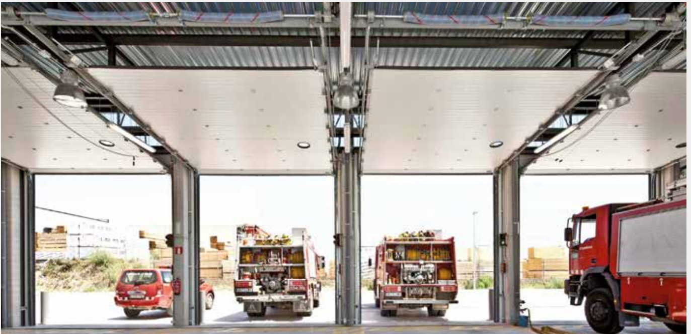
Vista interior de puertas seccionales sándwich en parque de bomberos.
