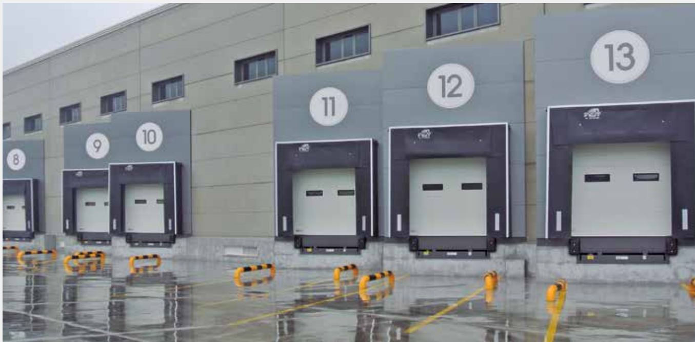
Puertas seccionales con mirillas en muelles de carga.
