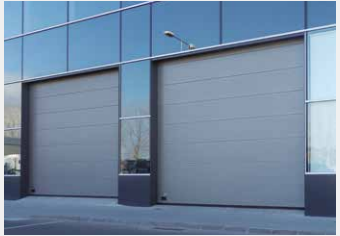
Puerta seccional panel sándwich microperfilado en empresa de automoción.
