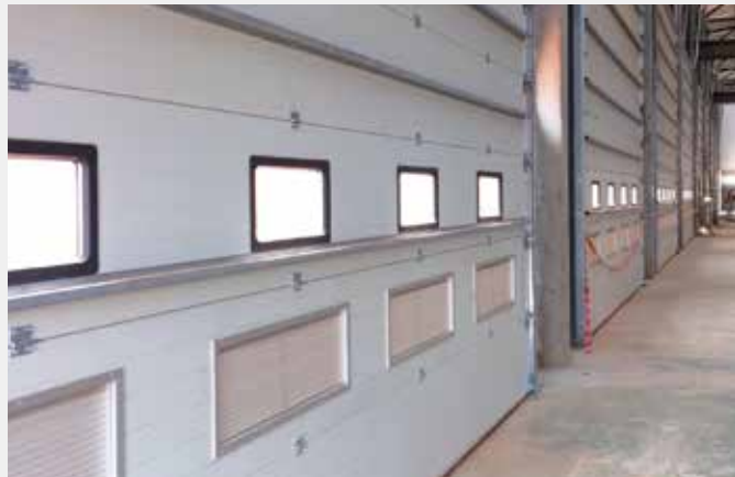
Vista interior de puerta con mirilla rectangular y rejilla de ventilación. Mirillas 610 x 350 mm. Rejilla 1050 x 360 x 35 mm.
