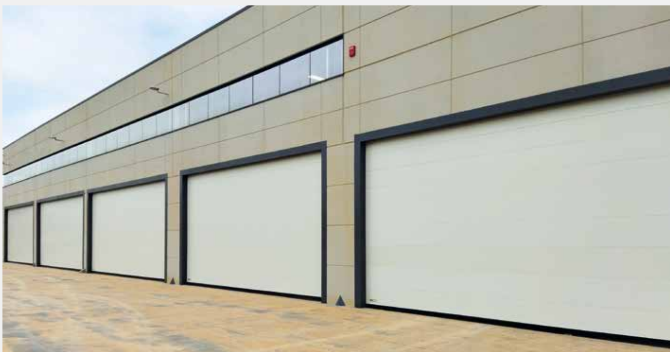
Puertas seccionales de 10 metros de ancho en Málaga.
