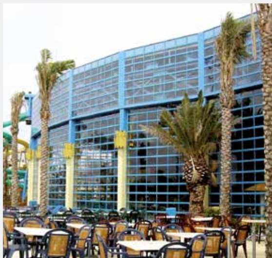
Vista exterior de puertas seccionales Alu-Secc ® acristaladas en parque acuático con fijo superior acristalado.
