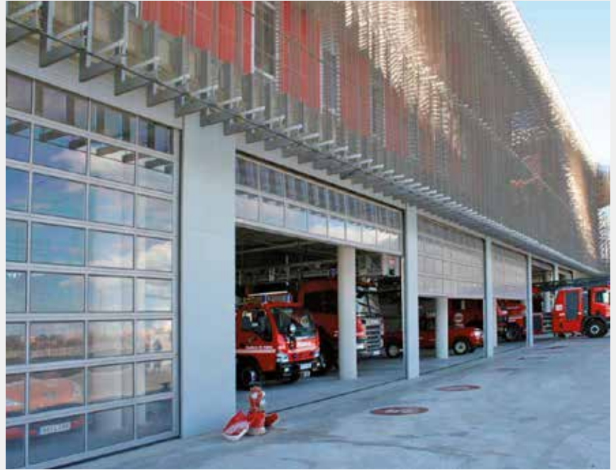
Puertas Alu-Secc ® en parque de bomberos.
