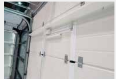
Detalle muelle retenedor y micro de seguridad.
