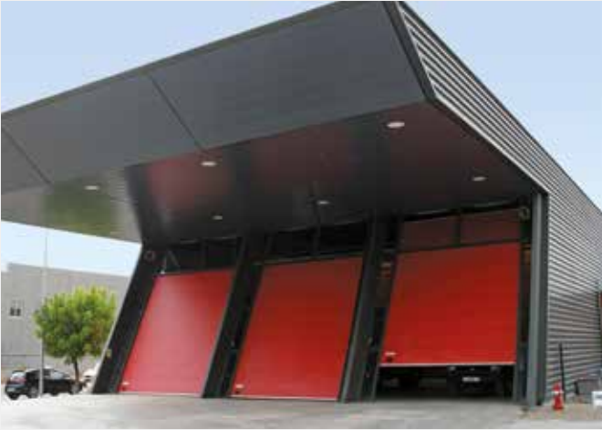
Puertas seccionales inclinadas en parque de bomberos.
