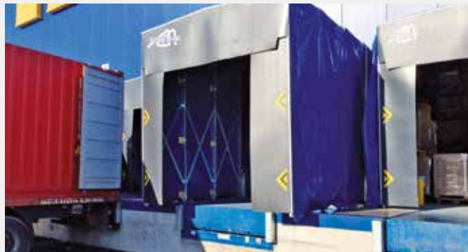
Abrigos extensibles en muelle de carga.
