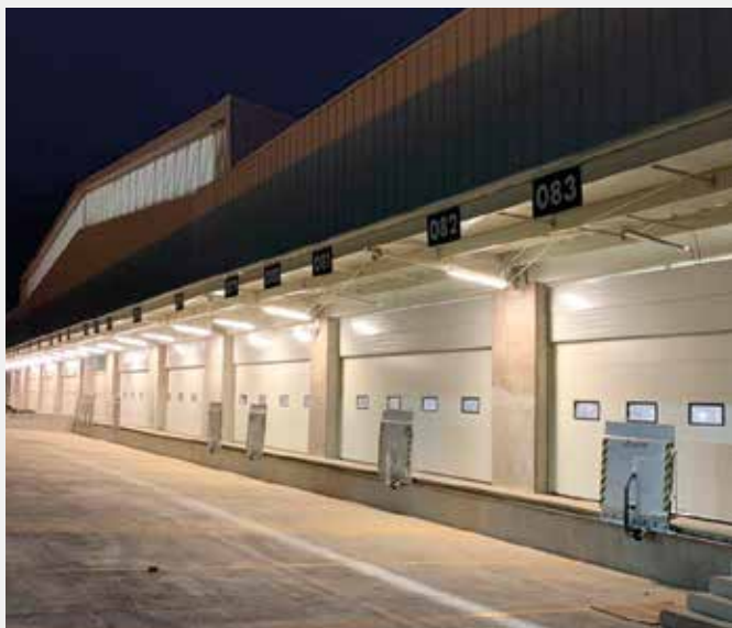
Muelle de carga con pasarelas de aluminio .
