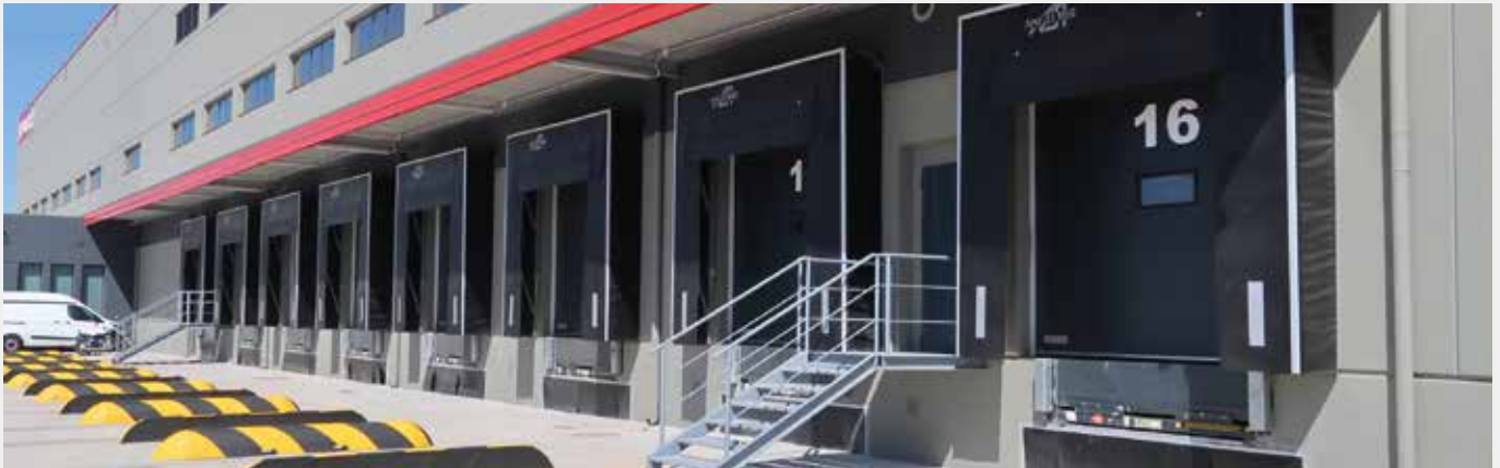
Rampas Hidra con abrigo AB y puerta seccional.
