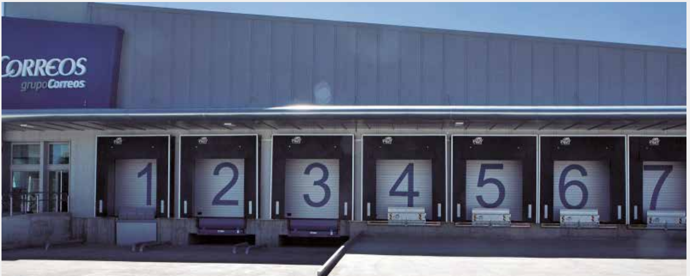
Mesa de muelle de carga, rampa HIDRA y pasarelas.
