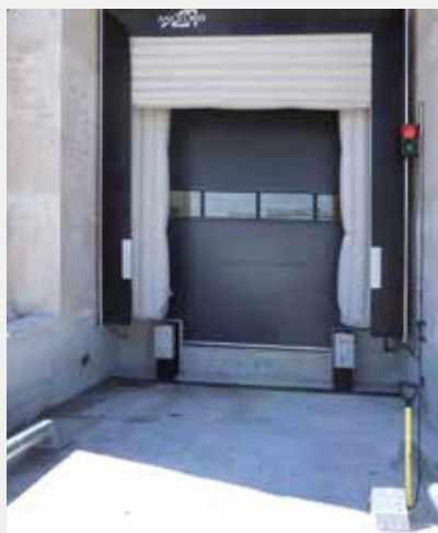
Abrigo hinchable AH ISO blanco, puerta Eco Dock y calzo Poly Chock Premium .
