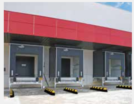
Conjunto de muelles Box B2 con topes de protección y guías.
