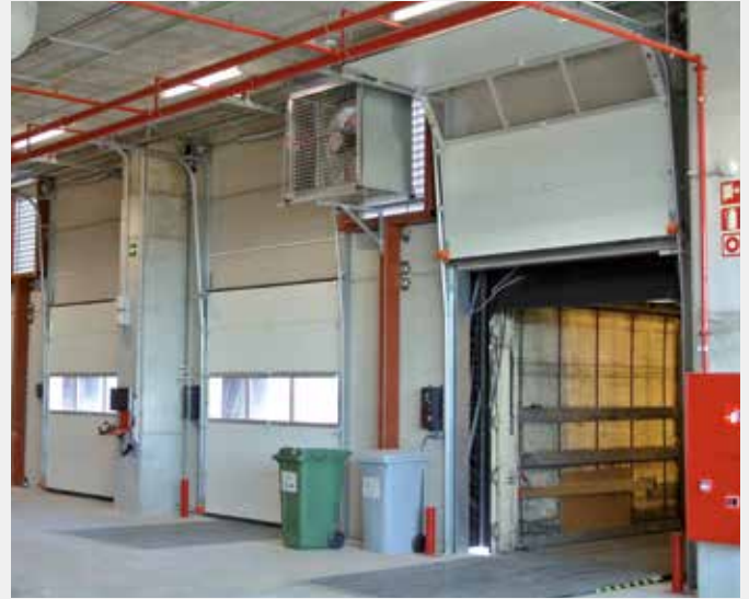
Rampa HIDRA y puerta seccional. Vista interior.
