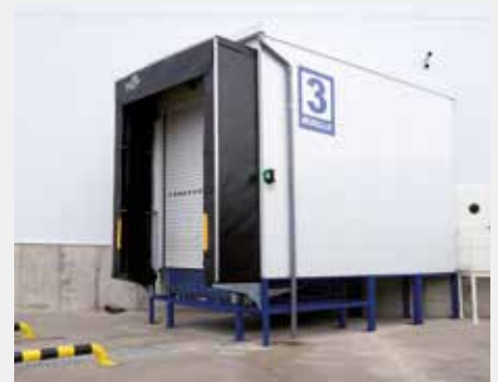
Construcción de muelle BOX B2 con inclinación de 45° a la nave industrial.
