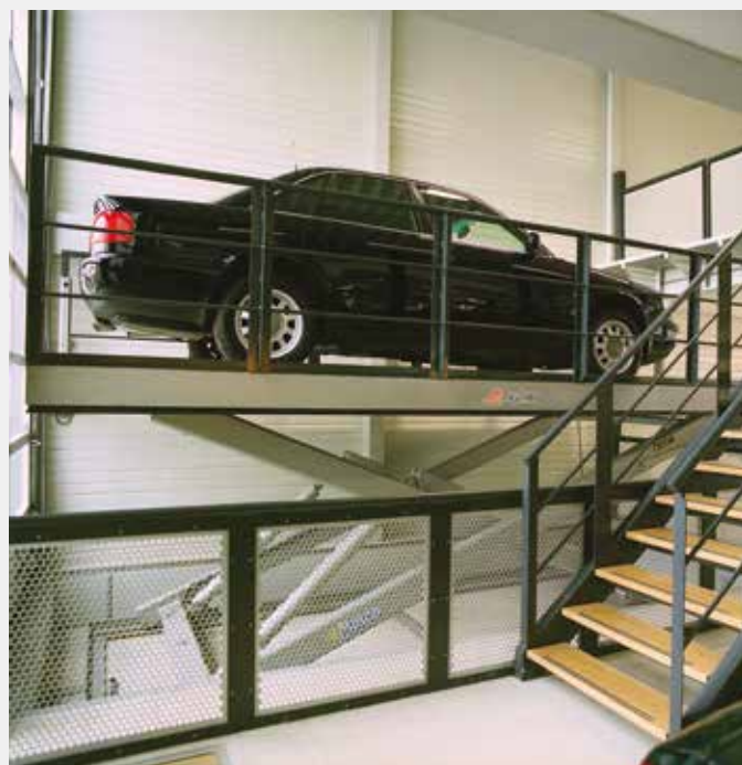
Barandilla de protección.
